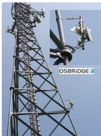
Instalacja dla firmy JAKO na potrzeby stadniny w Jarantowie
